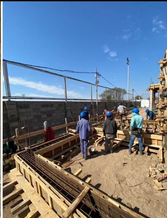
*Desenfofrado y Armado de Vigas de Fundación*
