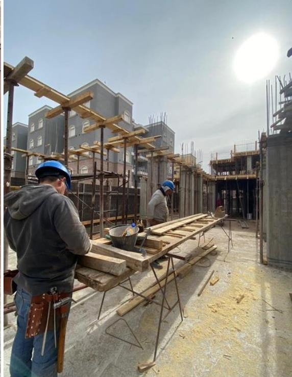
*Armado de encofrado para Vigas y Compactación de Suelo*
